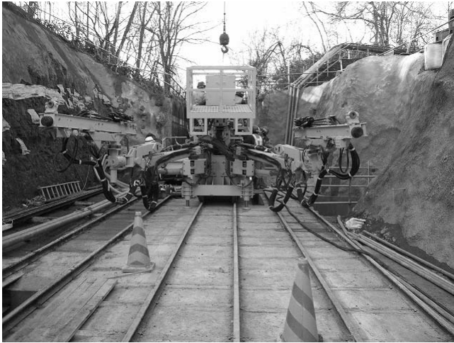
写真-10 坑外枕木コンクリート固定
