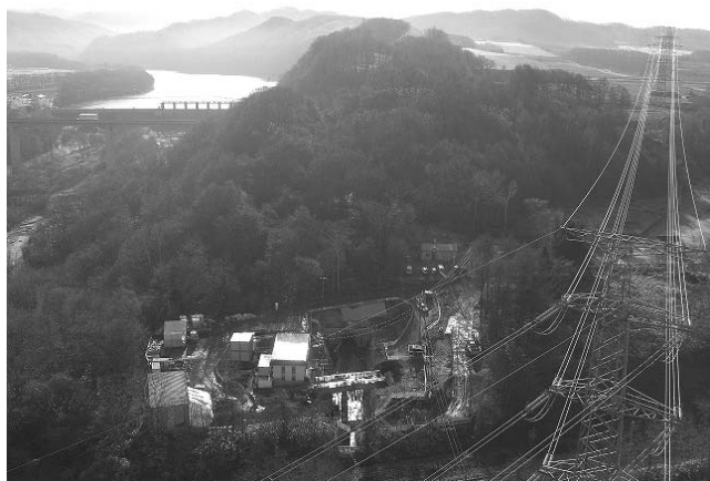
写真－2 工事区域写真
