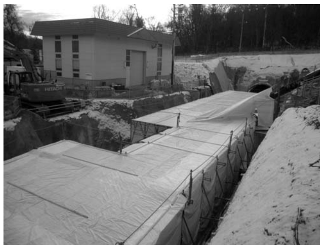
写真－4 坑外軌道設備養生囲い
