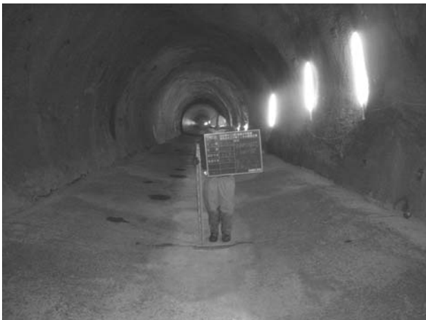
写真-11 掘削区間通水前
