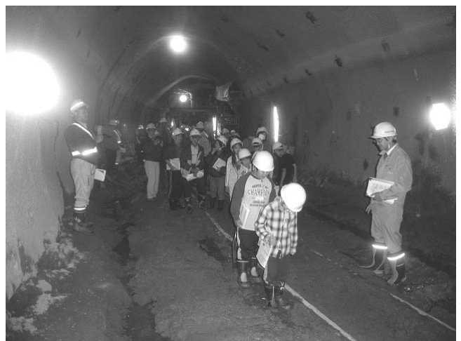
写真-12 川端小学校の現場見学会
