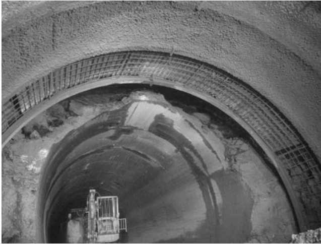
写真－７ 鋼製裏型枠設置状況
