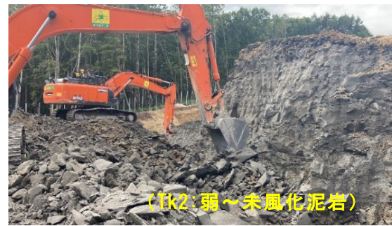
写真-1 泥岩(Tk2層)の掘削状況
