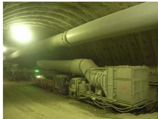
写真一 3 風管および集塵機設置
