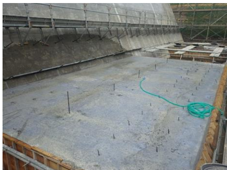
写真-13 自動散水養生状況
