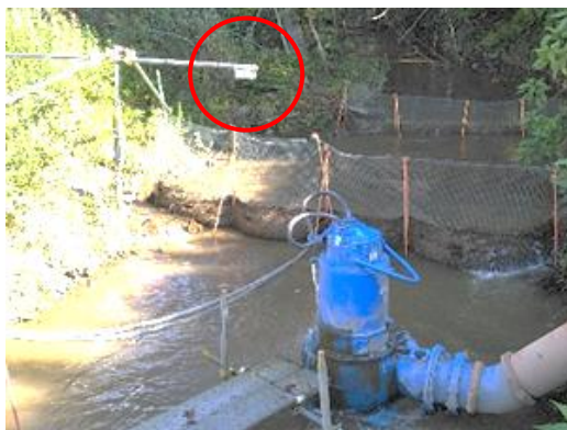
写真-3 水位計設置状況
