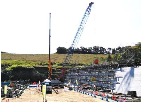
写真-10 クレーン打設状況
