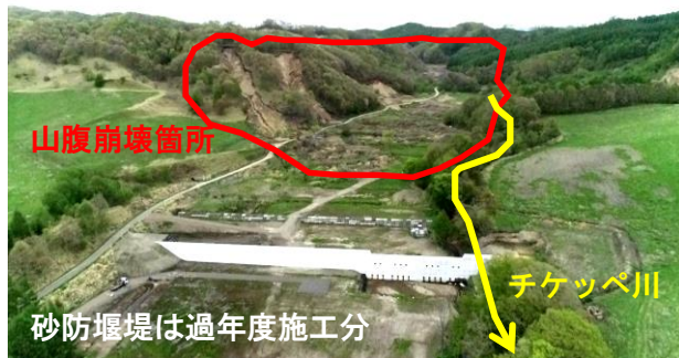
写真-1 砂防堰堤施工箇所周辺状況
