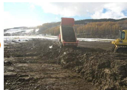
土砂が流出した農地へ運搬し、
