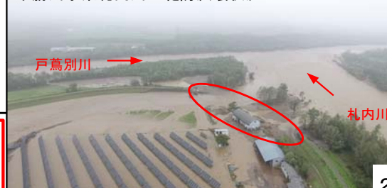
十勝川水系札内川の堤防決壊状況
