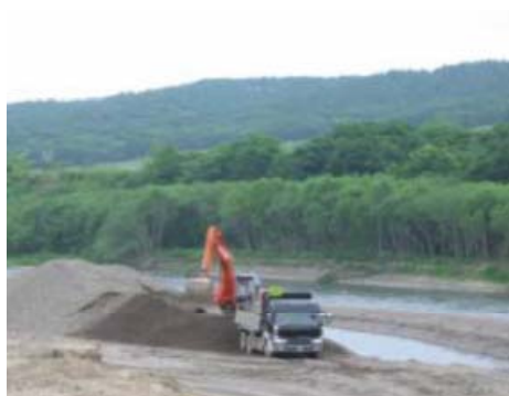
河道掘削した土砂を、
