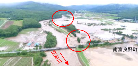
石狩川水系空知川の堤防決壊状況
