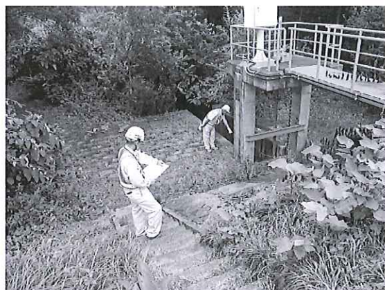
河川パトロール（樋門損壊の有無）状況
