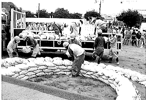
水防訓練(月の輪工法)
