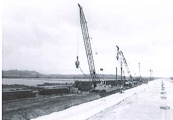
釧路沖地震による築堤崩壊復旧作業
