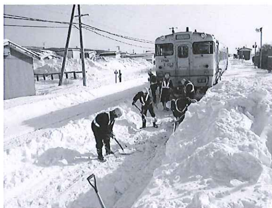
雪害によるJR北海道の復旧作業
