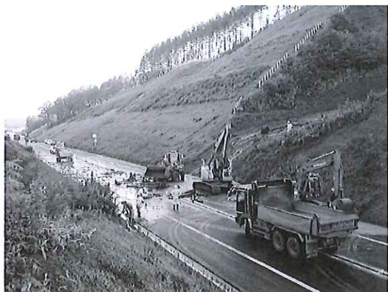
台風災害による東日本高速道路復旧作業
