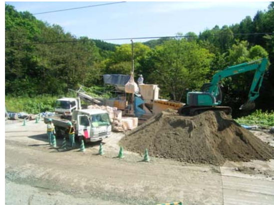
写真4-4 不溶化剤攪拌混合状況
