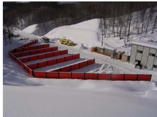
写真4-5 不溶化処理後堆積・養生用ヤード
