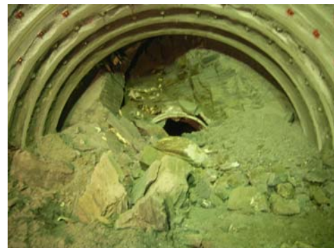
写真 4-2 断層帯近傍での崩落状態
